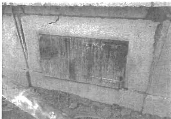
obr. 2 a 3 Sokl - kovová dvířka (2) a vystupující znečištění na povrch kamene (3)
