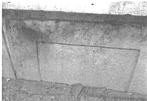
obr. 2 a 3 Sokl - kovová dvířka (2) a vystupující znečištění na povrch kamene (3)
