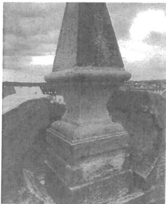
obr. 7 a 8 Detaily - Tympanon (7) komparace jižní strany se západní exponované (středový obelisk) a kryté (pravý segment); Dvěřní ostění zbytky historicky nehodnotných barevných vrstev
