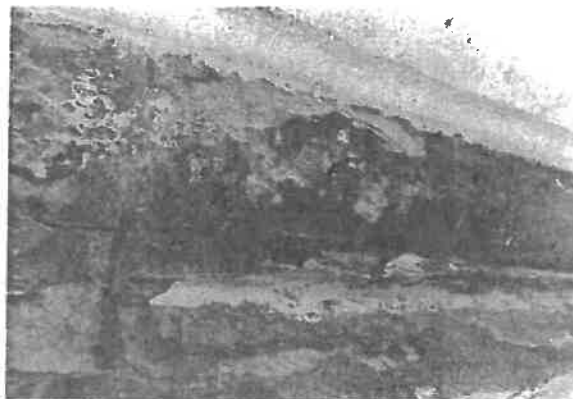
obr. 5 a 6 Tympanon - detailní fotografie poškození, korodovaných kámen do hloubky až 2 cm (5) v kombinaci se silnou nepropustnou vrstvou zčernalých depozitů a tvorba puchýřů (6 deformace povrchu horniny a tvarosloví prvku)
