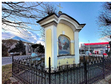
Trojbokou kapličku u benzinové pumpy čeká oprava.
