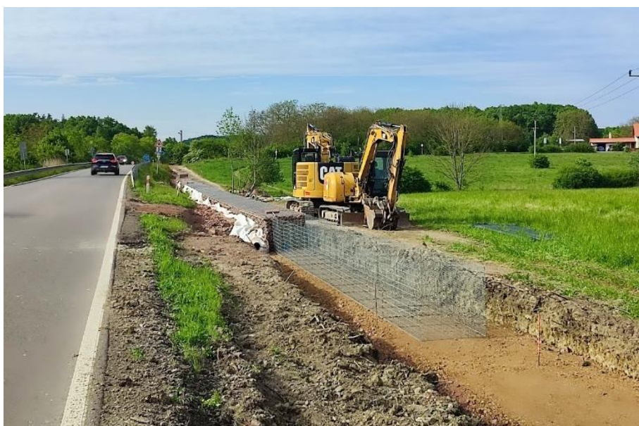
Stavba cyklostezky u Spyty.
