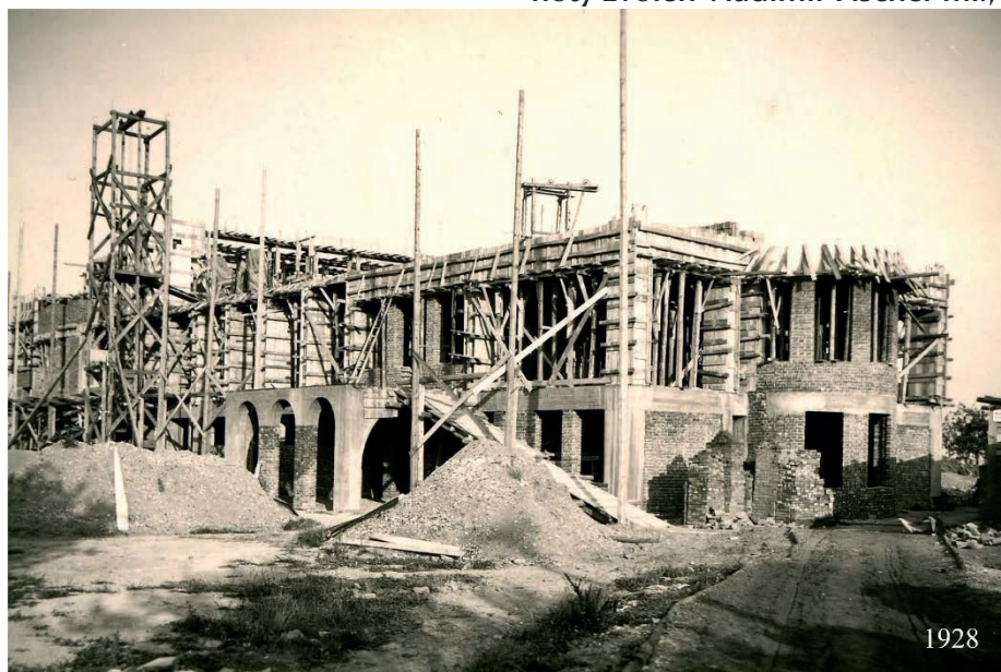
Stavba sokolovny v roce 1928.
