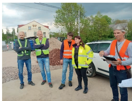
Kontrolní den na staveništi ve Zlíči.
