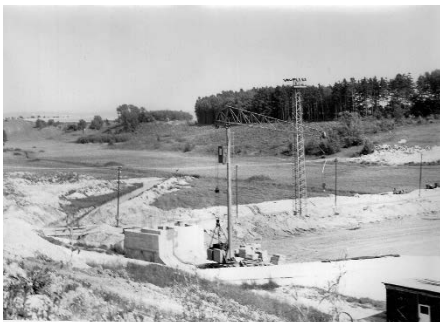
Stavba přehrady u Spytý v roce 1967.
