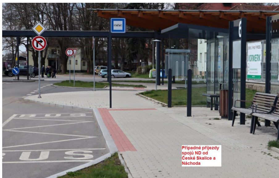
Detail Česká Skalice – nástup a výstup na autobusových zastávkách
