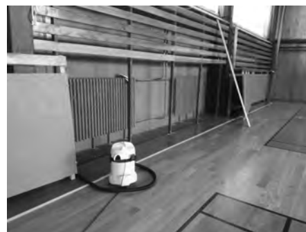
Sportovní hala se dočkala rozsáhlých oprav. Foto archiv ZŠ
