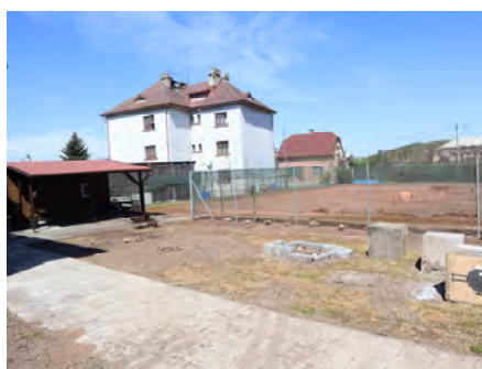
Rekonstrukce hřiště u sportovní haly.
