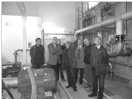
☛ Prohlídka zrekonstruované úpravní vody. Foto Jan Holý
