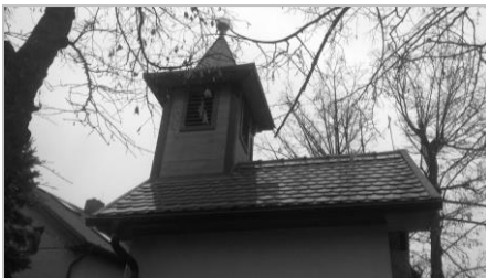
Kaplička v Zájездě se dočkala nové střechy a věžičky Foto: Martin Staněk
