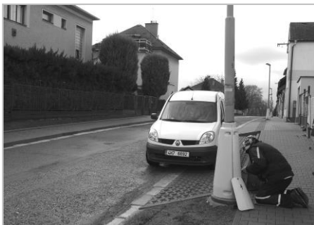
✚ Elektrikář Technických služeb při práci v Pivovarské ulici. Foto: Jan Holý
