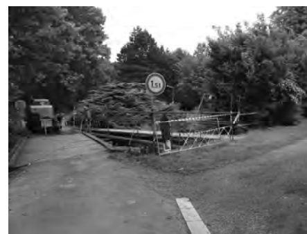
Rekonstrukce mostu u klubovny zahrádkářů. Foto Jan Holý
