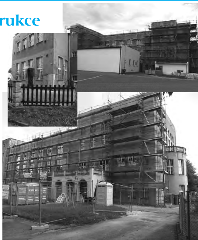
Rekonstrukce sokolovny v České Skalici.
