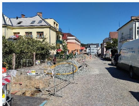
Stavební práce probíhají v ulici Komenského.
