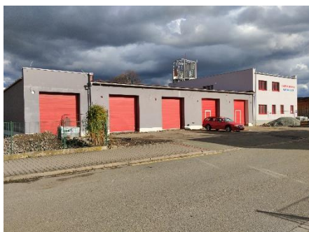
Rekonstrukce hasičské zbrojnice.
